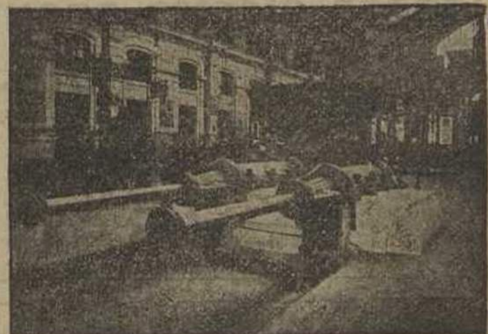
Apparelhos hydraulicos de parada, de curso de 7 pés, fornecido ao Caminho de Ferro Paris-Orleans
