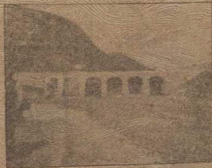
COMPORTAS NO RIO ALMA, ITALIA Vão de cada comporta de 10 metros. Profundidade de cada comporta 2,2 metros. Altura de elevação 4,3 metros.
