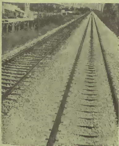
Trecho de via renovada na rede nacional
