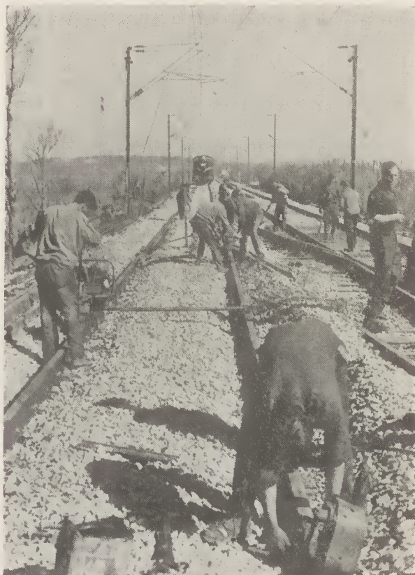
Fase de trabalhos de renovação da via
