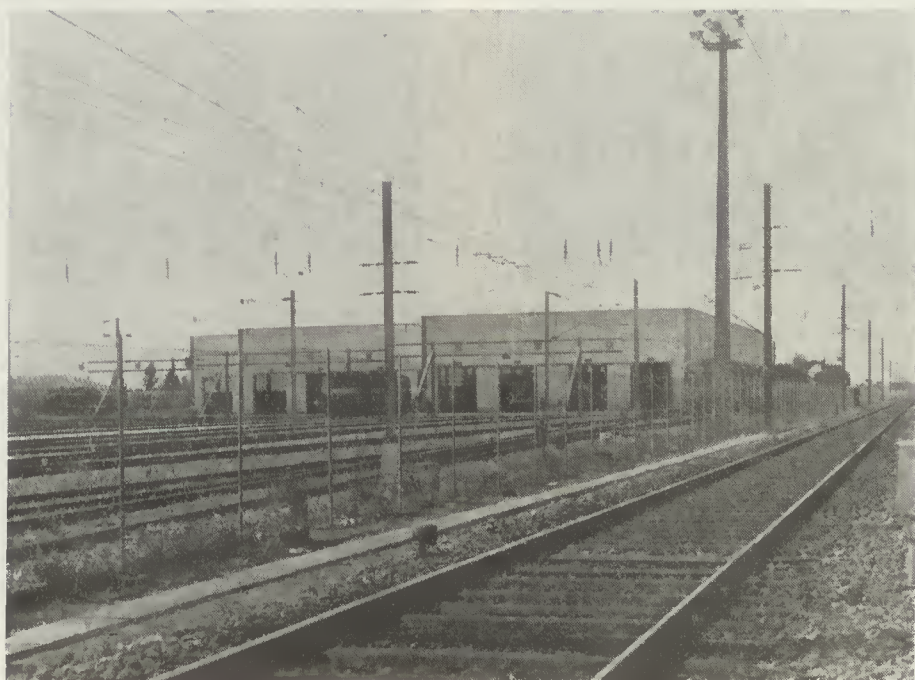
As oficinas da C. P. no Entroncamento
