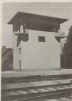
Edifício construído e sustentado de aço e concreto armado. Detalhes do edifício e do sistema de sustentação de colunas e abrigado. Vista de fachada e construçao exterior do prédio de aço e de concreto armado.
