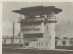
Vista de fachada e construçao exterior do prédio de aço e de concreto armado.
