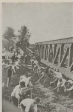
Operários em trabalho sobre a cidade para construção do pontilhão de ferro e sobre a ponte de madeira sobre o rio.
