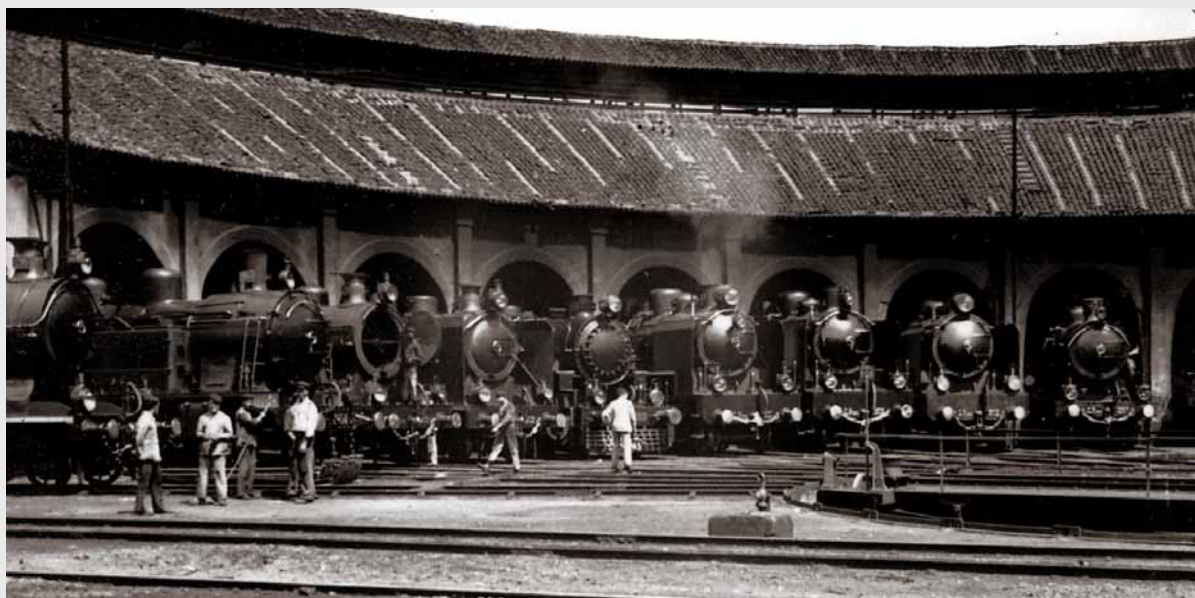
Depósito de locomotivas - Barreiro.
